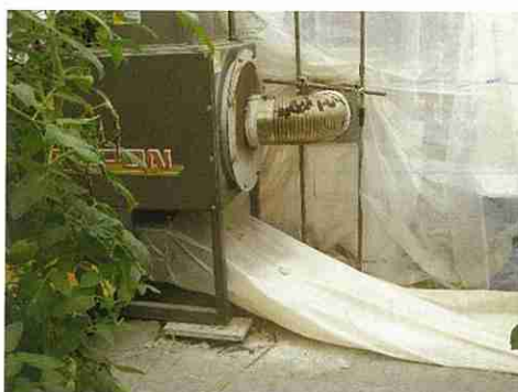
親ダクトに投入口を設置
